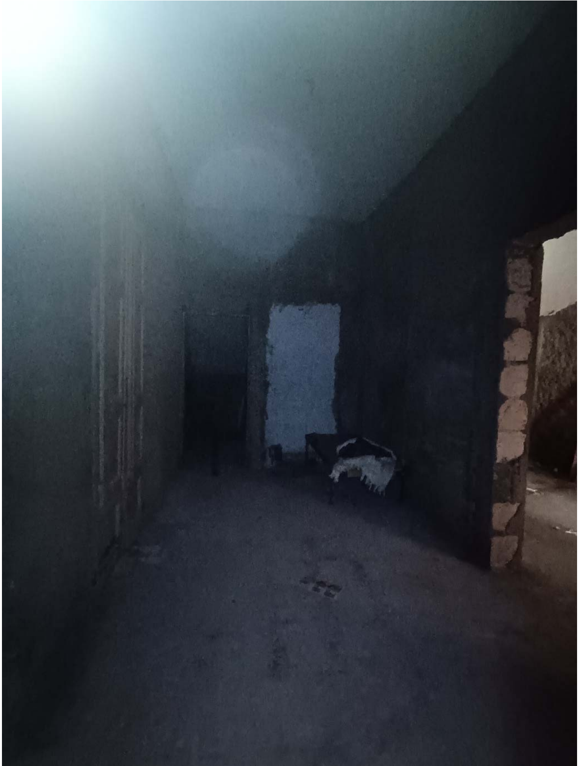
Foto 6- Vano n 4 con particolare in fondo apertura porta sottoscala e a sinistra porta prospiciente pozzo luce
