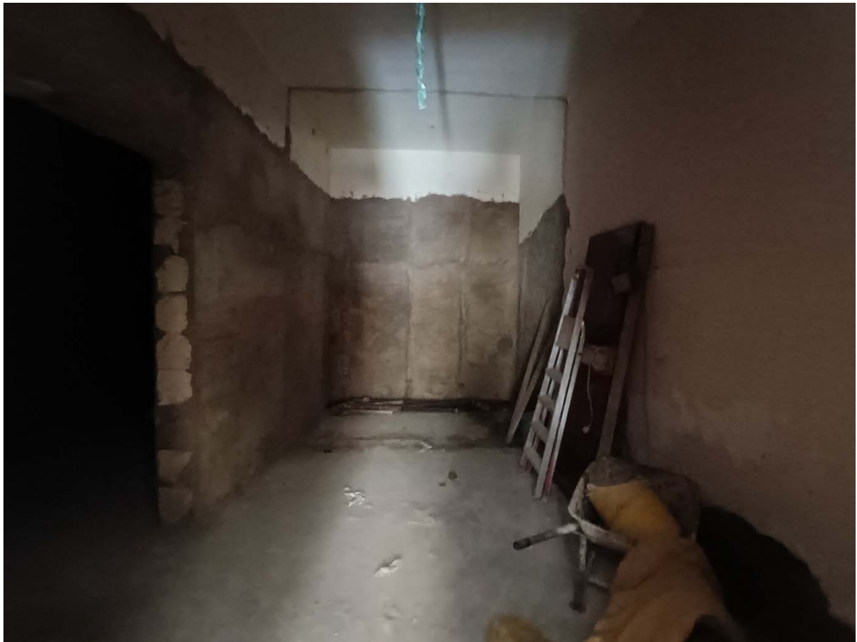
Foto 5- Vano n 3 con a sinistra apertura verso vano n.4
