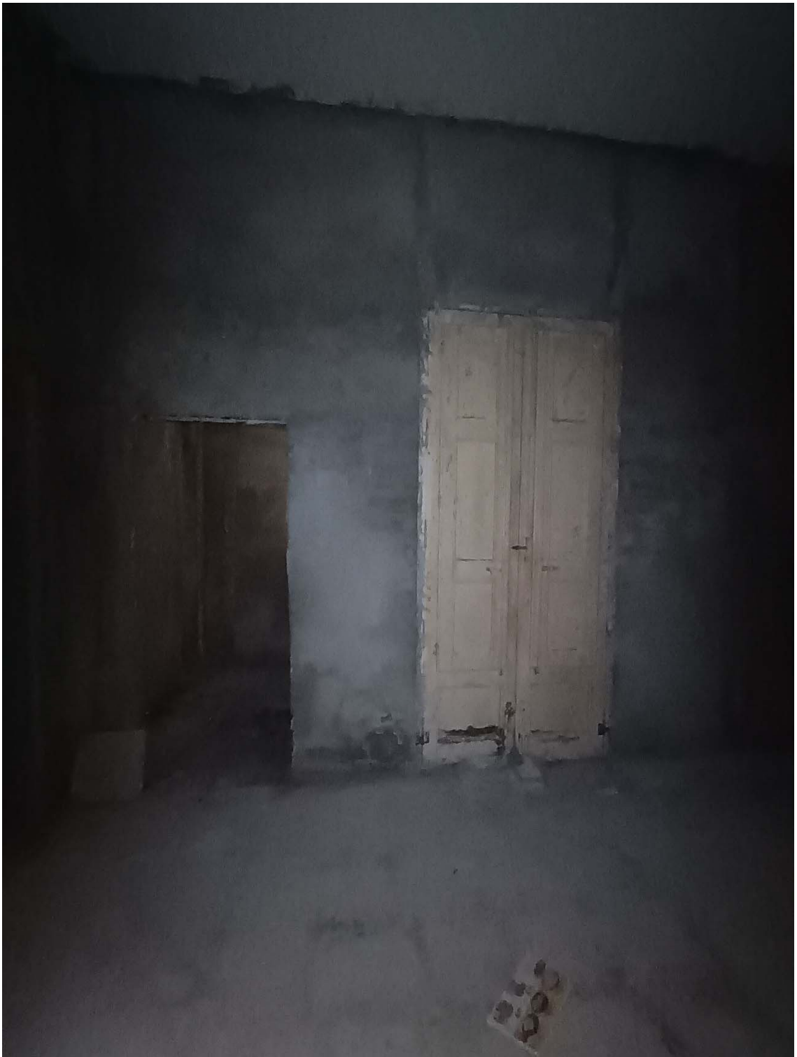
Foto 8- Particolare ingresso pozzo luce a destra e ripostiglio a sinistra
