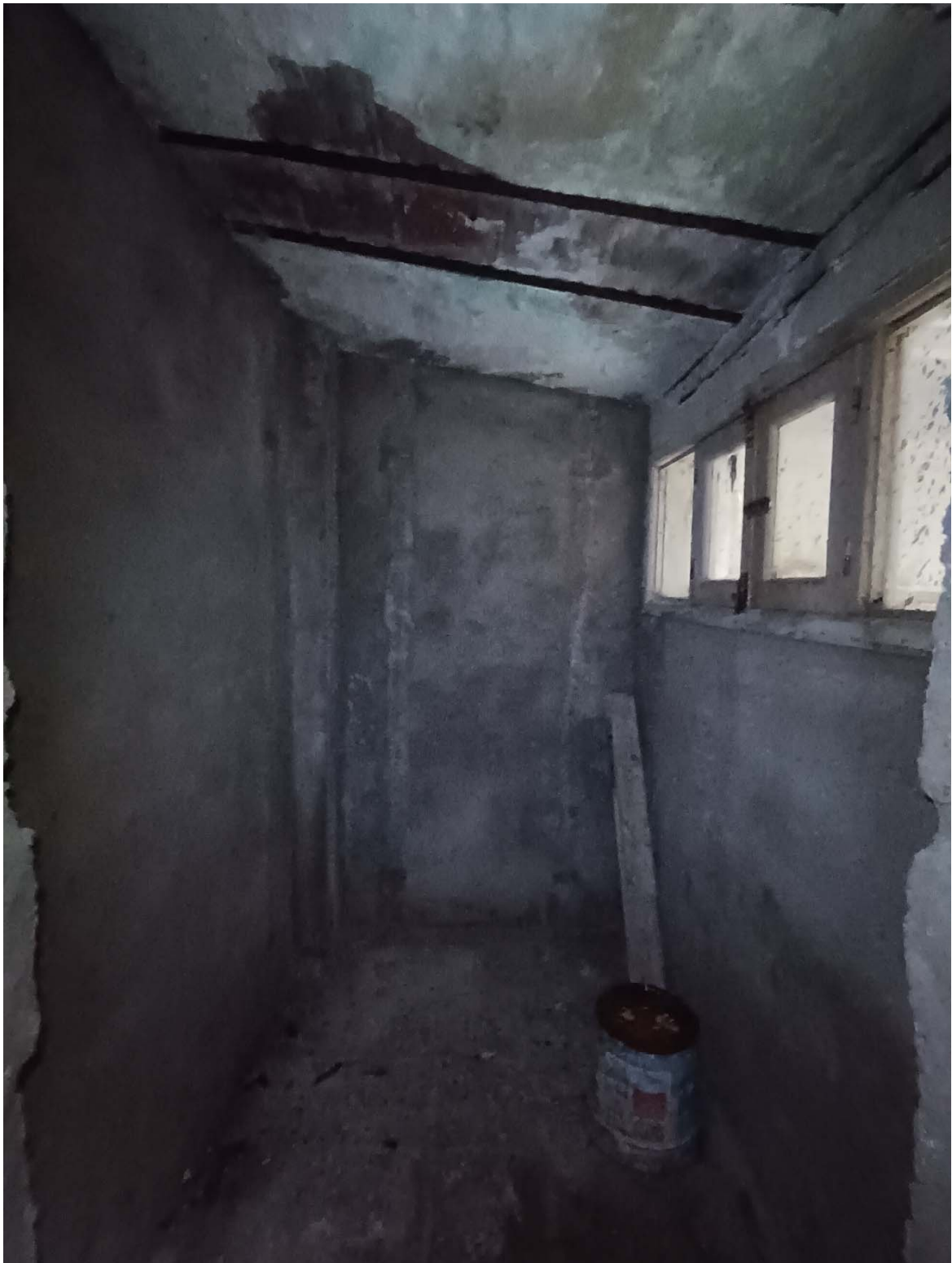
Foto 9- Ripostiglio con particolare finestra su pozzo luce
