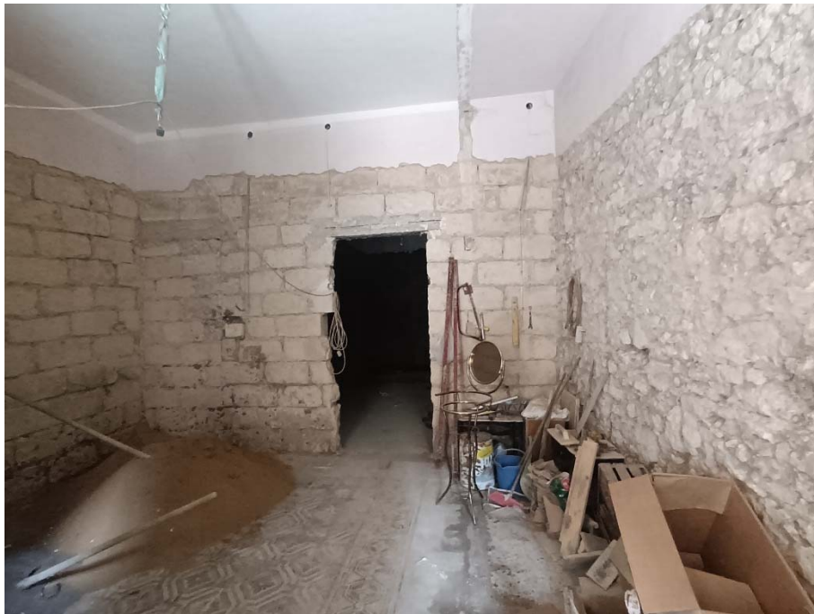
Foto 4- Vano 1 con apertura verso vano n.3
